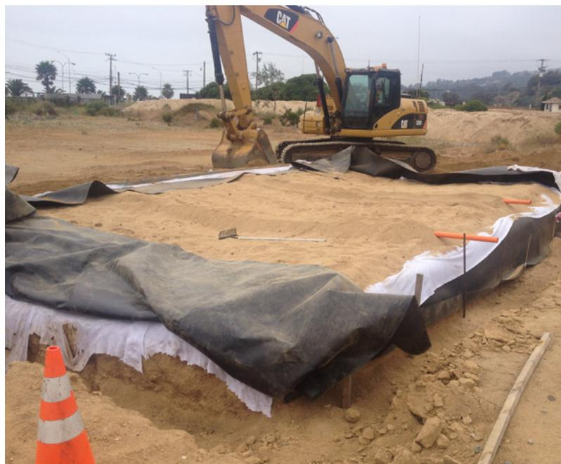
Fotos izquierda y derecha: Faenas de extracción de suelo realizadas en Las Salinas para pruebas piloto de biopilas a escala semi industrial. (Fuente: archivo ILS)
