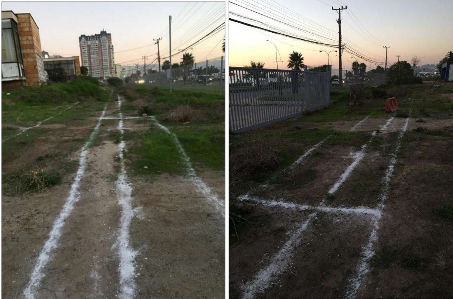
Imagen 1 - Inicio de obras 31 de Mayo 2017 - Trazado general sendero y zonas de descanso
