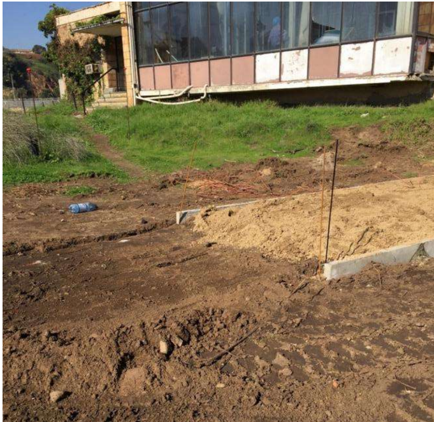
Imagen 3 - 26 Junio 2017 Instalación solerilla y maicillo para senderos peatonales
