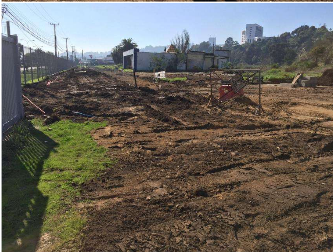
Imagen 2 - Escarpe y relleno – preparación de suelo Junio 2017
