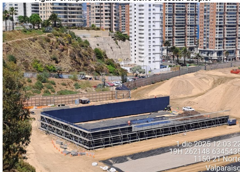
Figura 8: Implementación de cierre en sector acopio.
